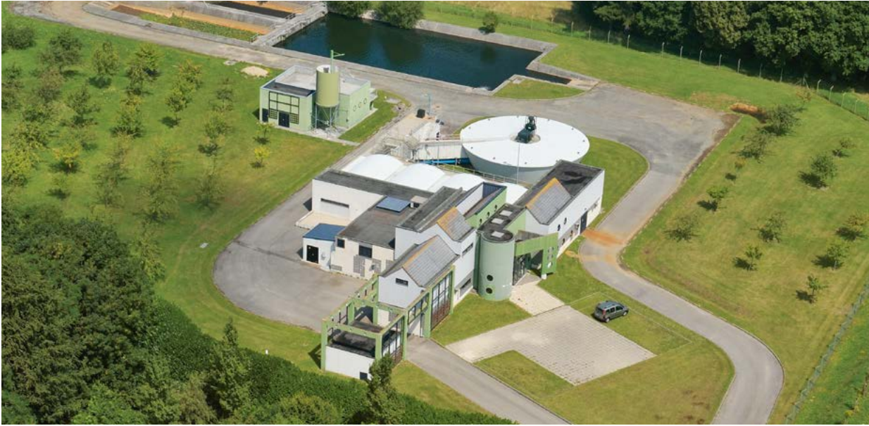
Usine de production d'eau d'Yport
