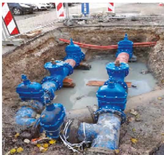
Chantier de réparation conduite de refoulement - Harfleur
