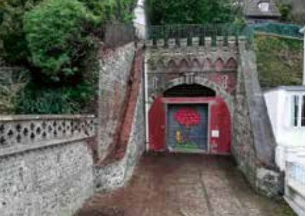
Tunnel Sainte-Marie, Le Havre
